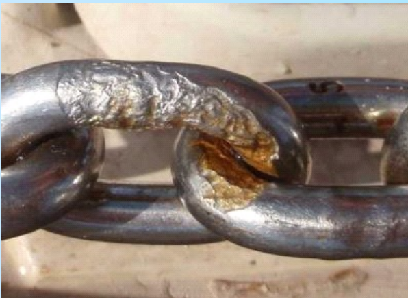
Abb. 1: Materialverlust durch Oberflächenkorrosion an A4-Kette
