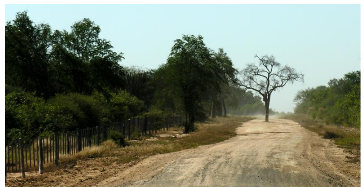
Hier wird der deutsche Straßenbauingenieur schwer schlucken, kein Einzelfall übrigens
