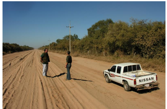
Die Fahrbahndecke ist weich gefahren, da weicht man neben die Straße aus (eine Regionalstraße)
