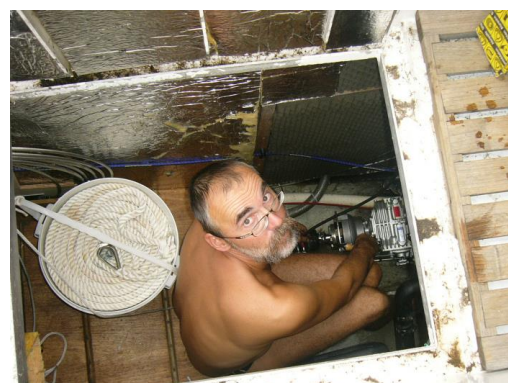
Arbeiten im Keller
